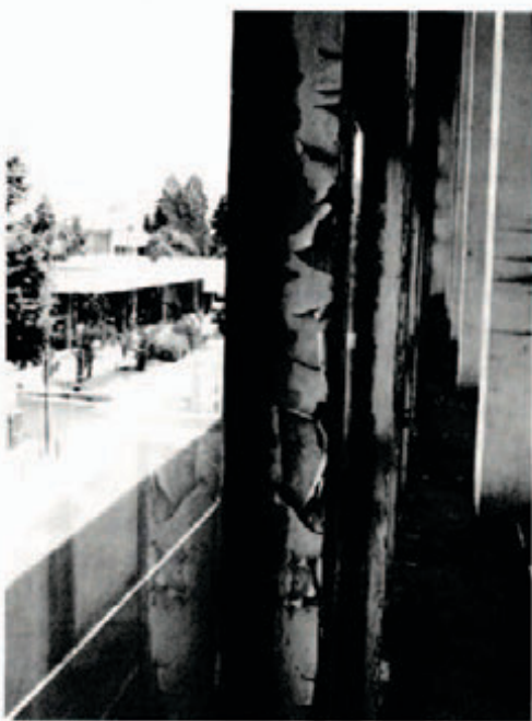
Ico Centrale: i telai delle facciate montati prima del restauro e dettaglio della facciata prima del restauro.
