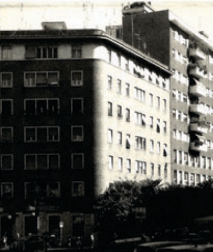
Edificio per abitazioni a piazza Istria, 1938 (foto Luciano Cupelloni)
