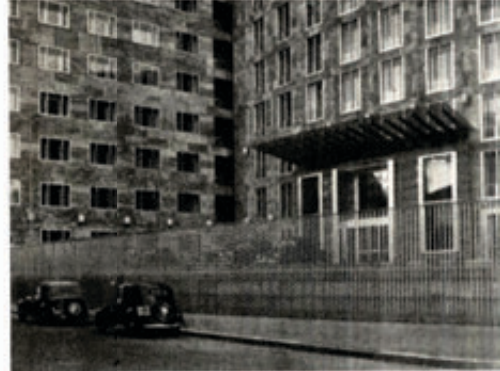
25. Fronte principale del Palazzo per Uffici Montecatini di Gio Ponti ("Casabella Costruzioni" 138_139_140, 1939)
