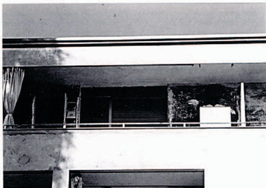
3-4. M. Nizzoli, A. Fiorchi, abitazione popolare a Canton Vesco, Ivrea, vista e particolare dell'ultimo piano del fronte principale prima dell'intervento del 1997
