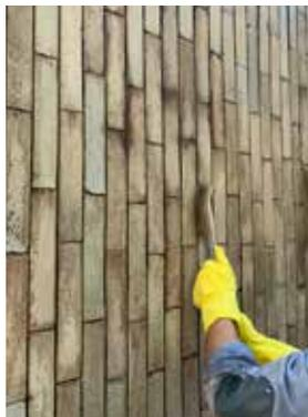
13. Prove di pulizia della facciata a nord compromessa da depositi vegetali e dall'erosione delle piante rampicanti.
