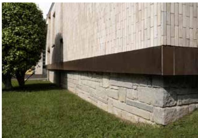
14 e 15. La facciata del soggiorno dopo il restauro. Sostituzione della cornice in grès degradata con profilo metallico preverniciato removibile, che dichiara la nuova integrazione nell'impossibilità di recuperare o riprodurre le piastrelle originali (ph. F. Oggero). A LATO\_16. Le condizioni di degrado e di instabilità del muro controterra in calcestruzzo faccia a vista prima del restauro.
