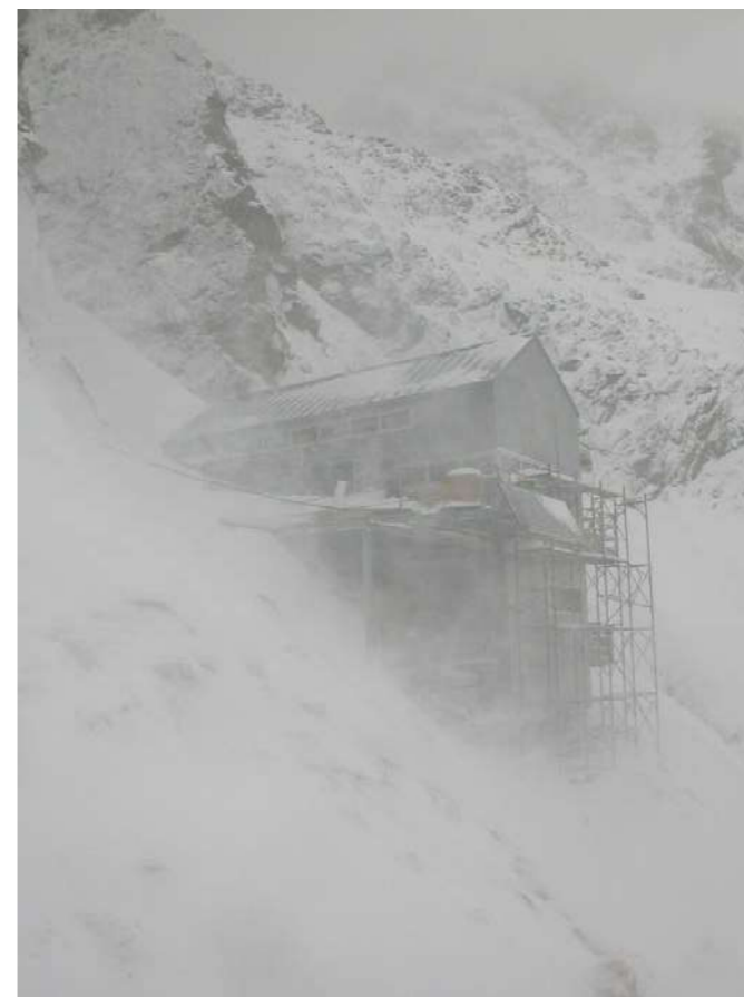
Cantiere del Rifugio Dalmazzi, 2584m, Val Ferret, Ghiacciaio del Triolet, Courmayeur
